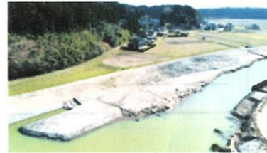
施工前写真 (真上) ②
