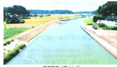
完成写真 (真上) ①
