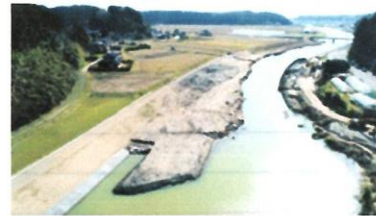
施工前写真 (真上) ①
